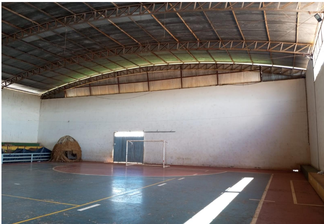
FOTO 5 – QUADRA CENTRO MULTIUSO
