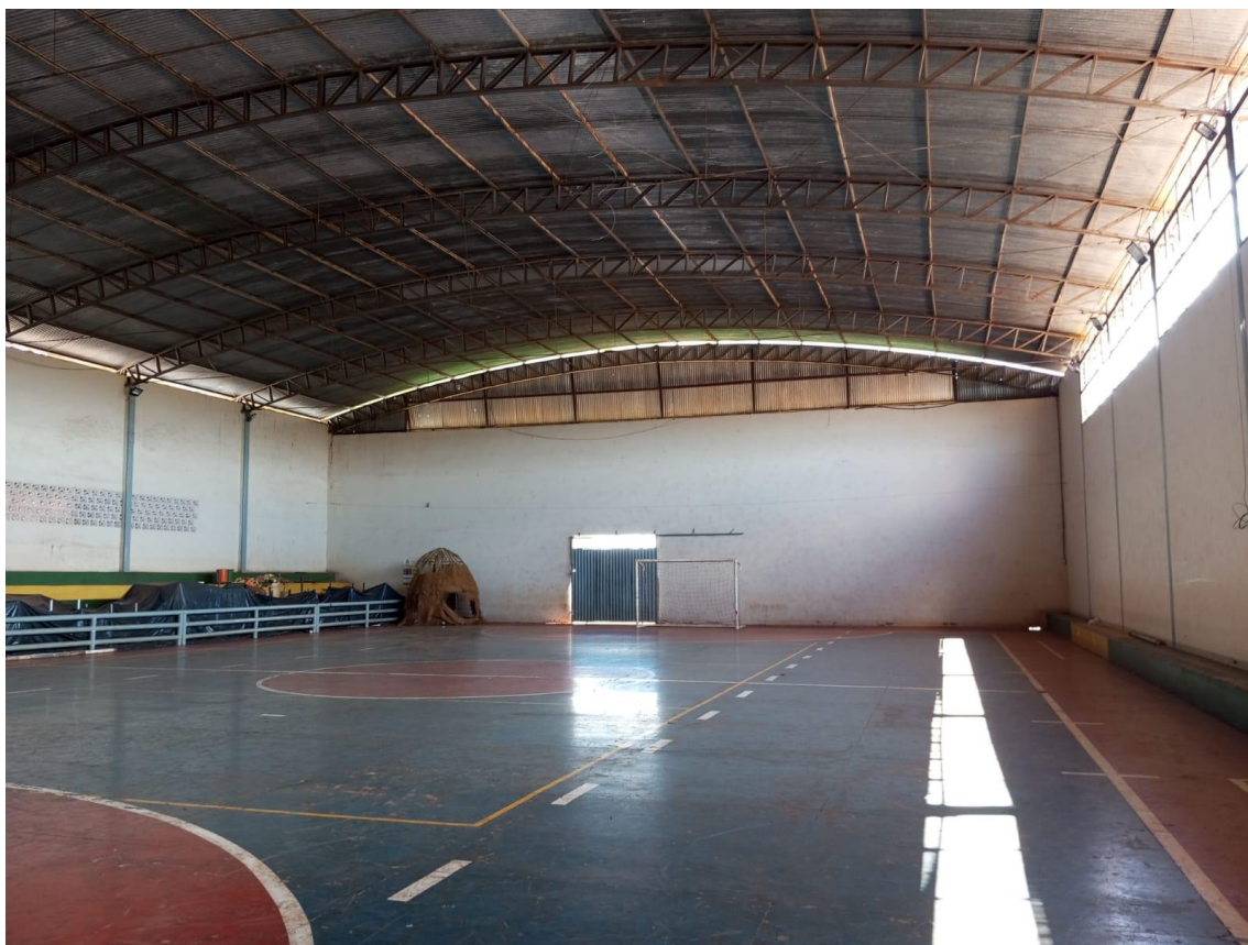
FOTO 4 – QUADRA CENTRO MULTIUSO
