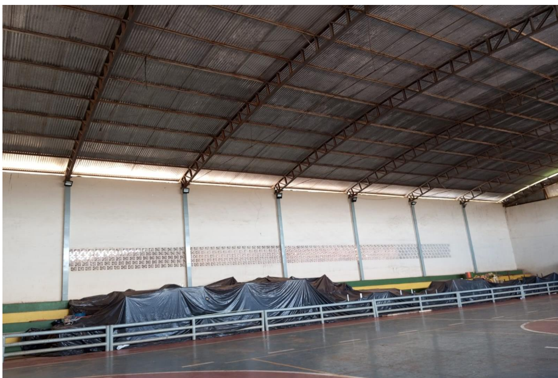
FOTO 6 – QUADRA CENTRO MULTIUSO
