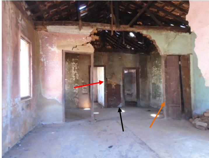
Figura 16. Paredes de pau-a-pique apresentam abaulamento e ausência de reboco e pintura. Indicada com seta vermelha parede do cômodo que serviu de consultório, seta laranja parede de divisa da cozinha. Foto Raquel Córdova Christófar. Agosto/2020.
