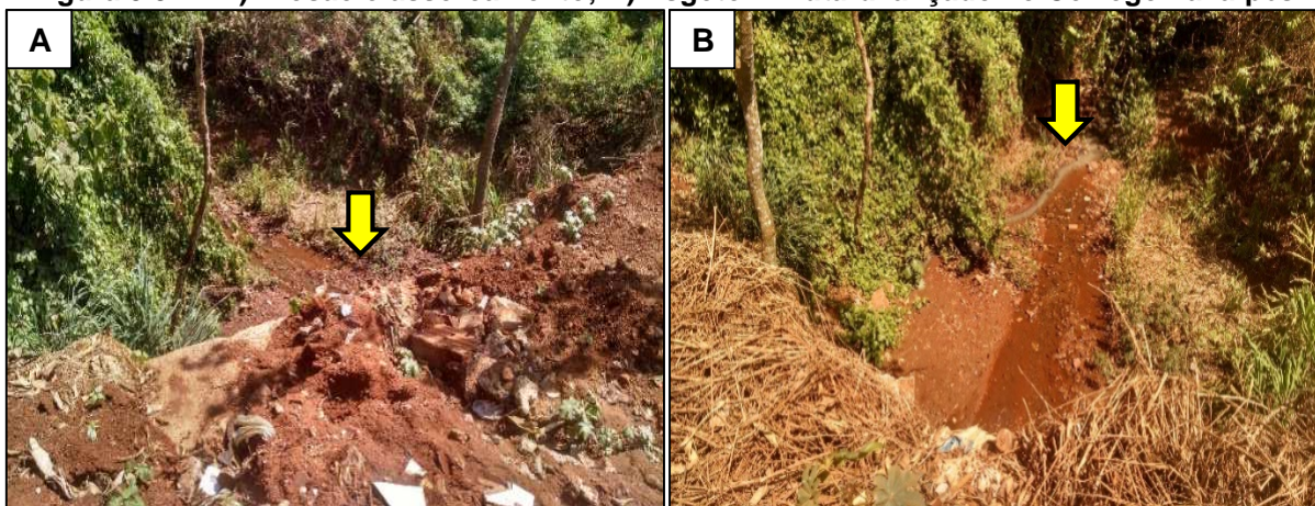
Figura 3.34 – A) Erosão e assoreamento; B) Esgoto in natura lançado no Córrego Lava-pés.
