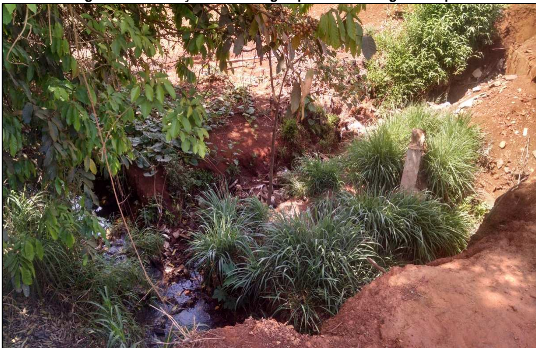
Figura 3.49 – Lançamento de água pluvial - Córrego Lava-pés.
