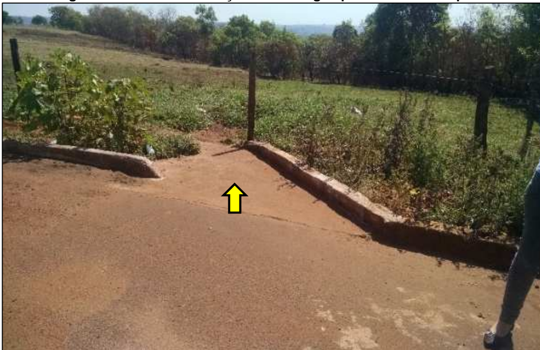
Figura 3.45 – Ponto de lançamento de água pluvial de Indianópolis.
