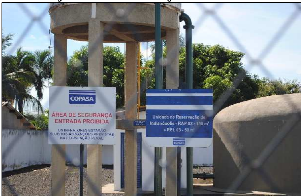
Figura 3.30 – Reservatórios de água tratada da COPASA.
