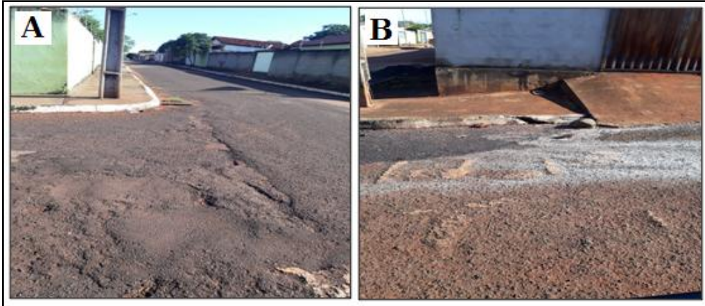
Figura 44: Tamponamento dos PV's na Rua Glicério Pereira
