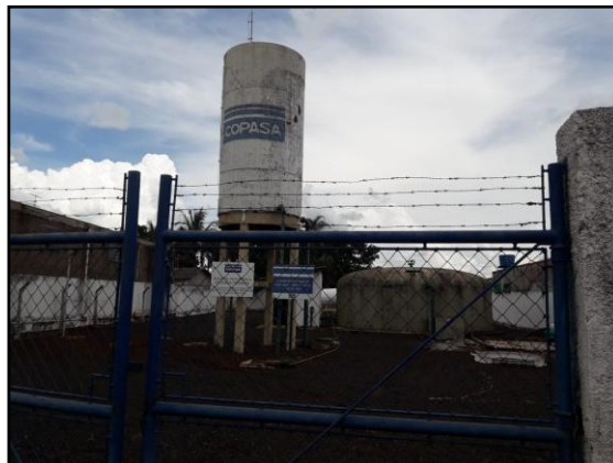
Figura 51: Reservatórios de água tratada da COPASA.
